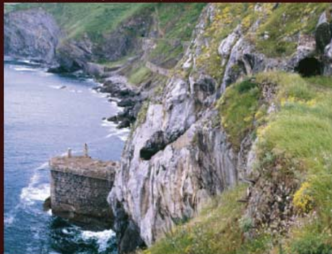
Pilastra que soportaba el cargadero vista desde La Punta de Saltacaballos, al final de la traza del plano inclinado que accedía al antiguo cargadero.
