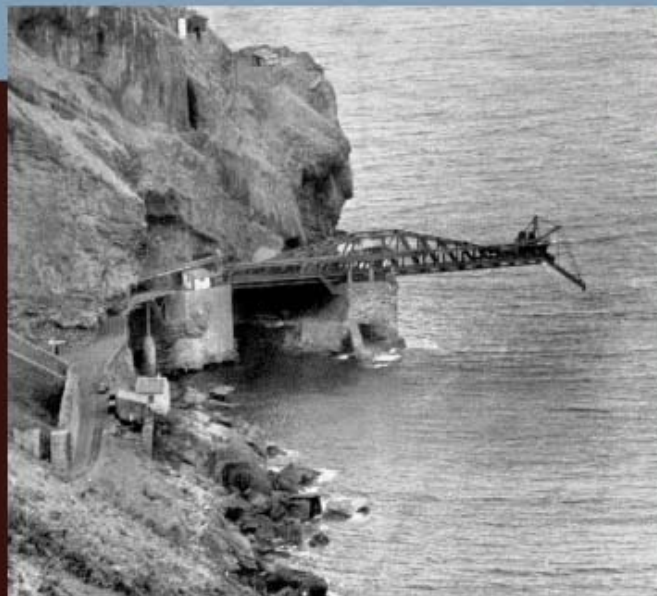
Cargadero de Saltacaballos de la Compañía Minera de Setares Construido por la casa Auguste Lecocq en 1888.
