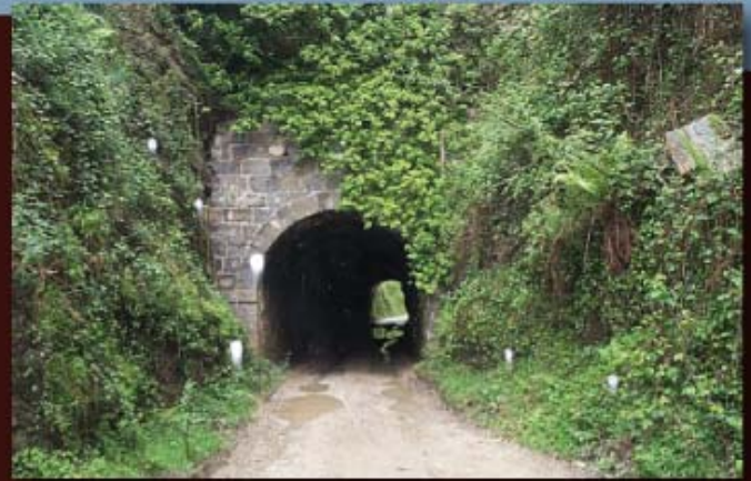
Boca sur del túnel de Matanzas.
