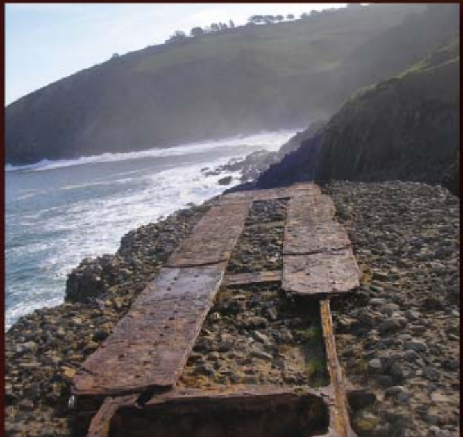
Restos metálicos del cantilever de El Piquillo
