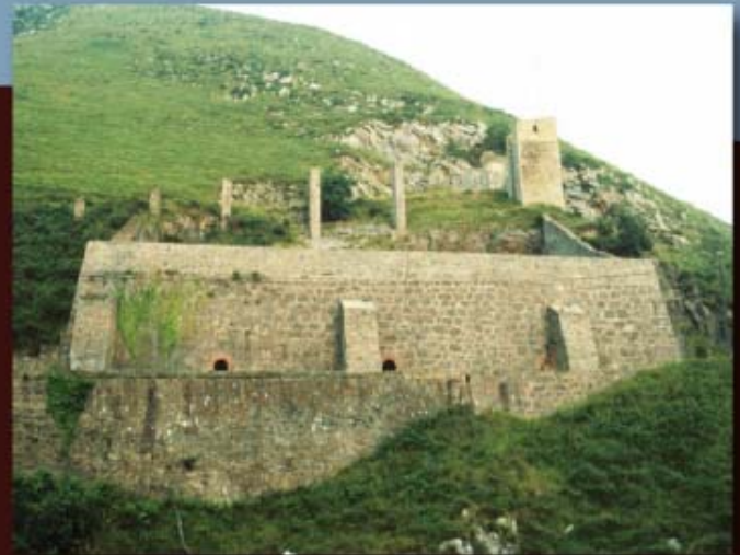
Vista de los depósitos sobre el muro de contención de la vía minera. En la zona superior los pilares que soportaban el plano inclinado.
