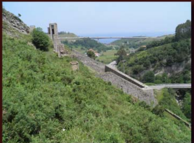
Vista lateral del depósito. Al fondo puede observarse el viaducto de la A-8 a su paso por Ontón.
