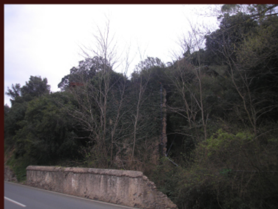
Ruinas de la estructura que soportaba el ascensor en el primer sistema de transporte (línea de baldes) de las minas de Dícido, posteriormente reutilizado, y que permitía el paso del mineral por debajo de la N-634 para su posterior conducción a la zona de embarque en la costa de Dícido.
