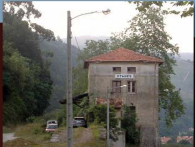
Antigua estación de Otañes. Fachada norte. Año 2007
