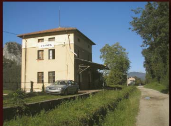
La estación en el año 2007, antes de su rehabilitación .
