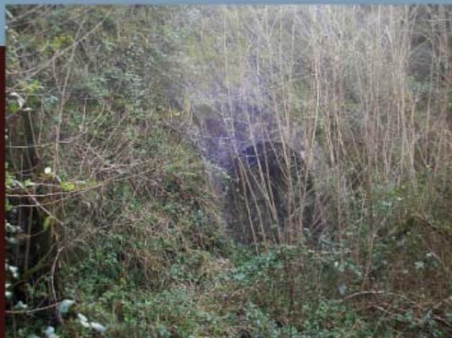
Una de las bocas del depósito.
