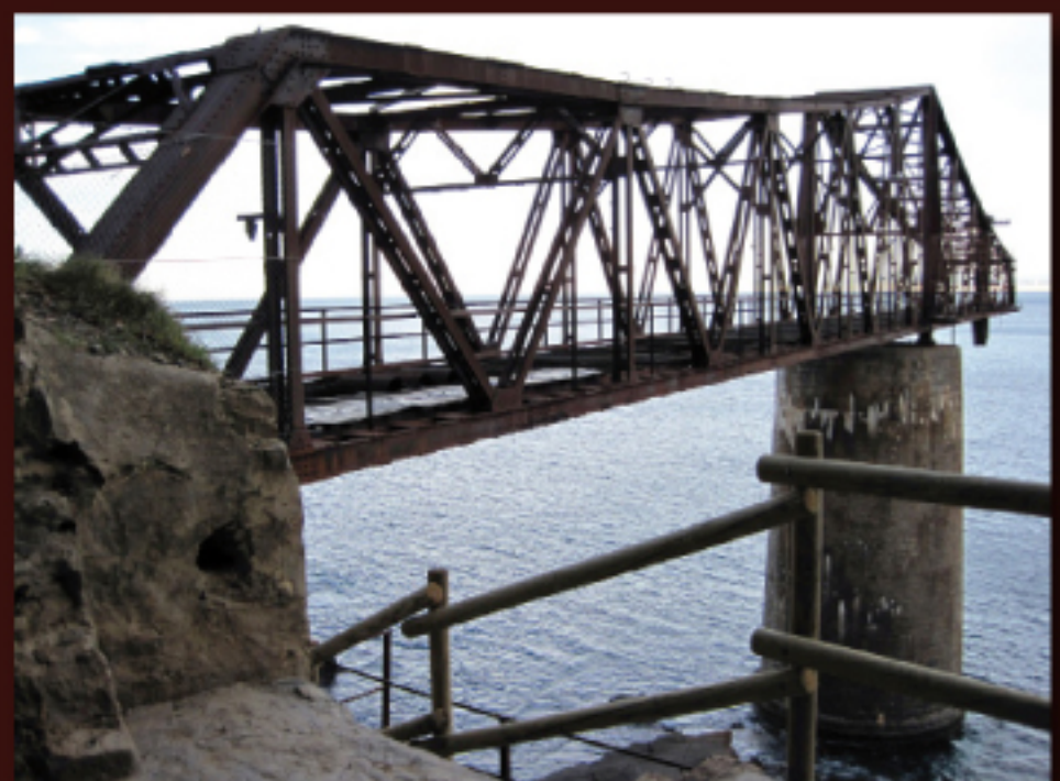
Estructura del cargadero.
