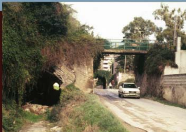
A la izquierda, uno de los túneles de Alén en 1993.
