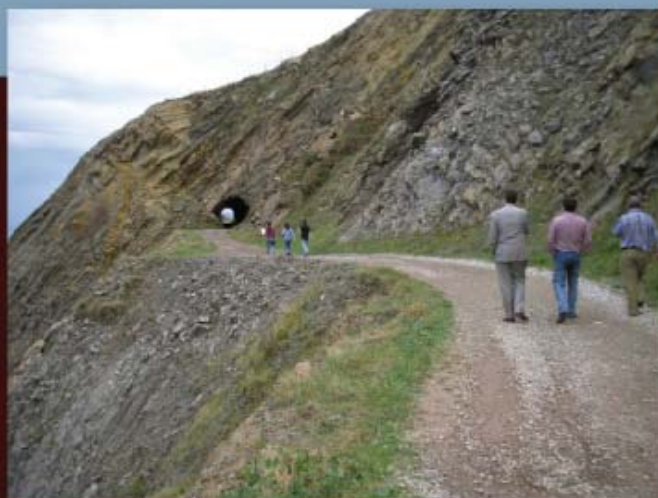
La ruta del Piquillo antes de su restauración con el túnel al fondo.
