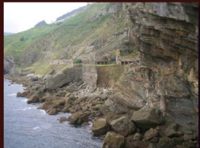
Vista desde el Oeste de los depósitos de mineral.
