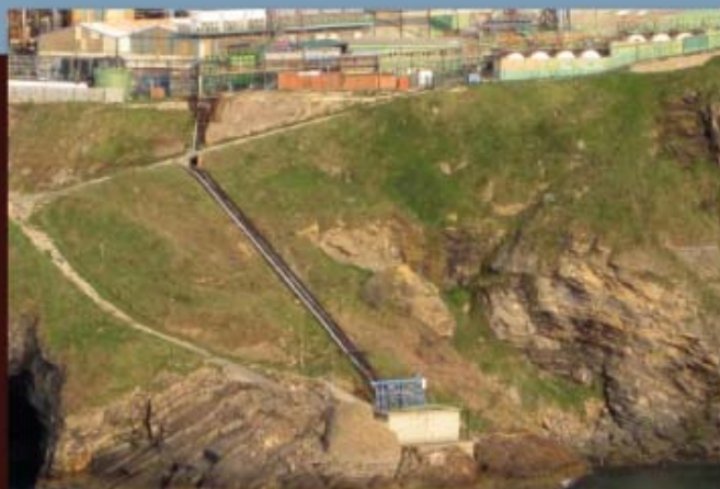
Los restos de la antiguo cargadero se encuentran a la izquierda de las instalaciones de bombeo de Derivados del Flúor, S.A.
