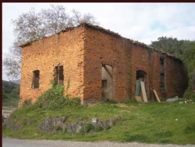
Estado actual de la construcción, desde el paseo hacia el cargadero .
