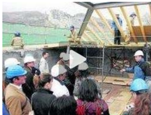
Las autoridades recibieron las explicaciones del jefe de obra en la planta alta del edificio. /A. VERANO
