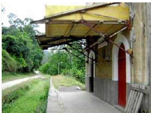
La estación es un edificio de propiedad municipal. / M. C.
